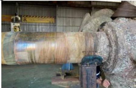
Gambar 5. Kerusakan pada Outboard Bush Port Side
