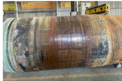
Gambar 8. Kerusakan pada Inboard Bush Starboard Side
