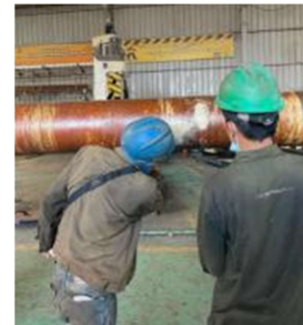
Gambar 13. Aplikasi dempul pada retakan fiber
