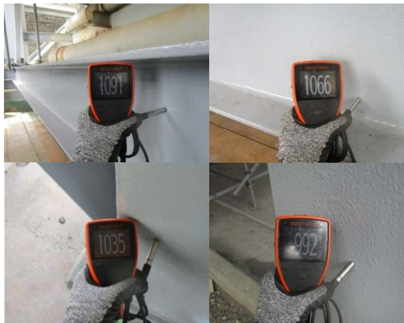
Gambar 5. Pengukuran ketebelaan lapisan Top coat .
