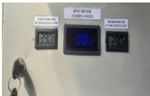
Gambar 8. Pemasangan Sensor Temperatur
