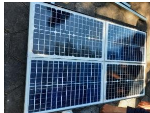
Gambar 5. Pemasangan PV pada Rangka
